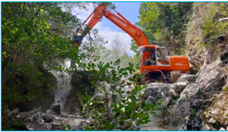
Démolition du barrage au moyen d'une pelle de 22 tonnes équipée d'un brise roche hydraulique. Remise en forme du lit et retalutage léger de la berge.
