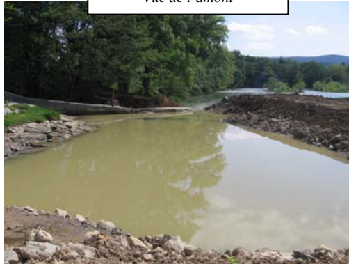
Vue de l'amont
